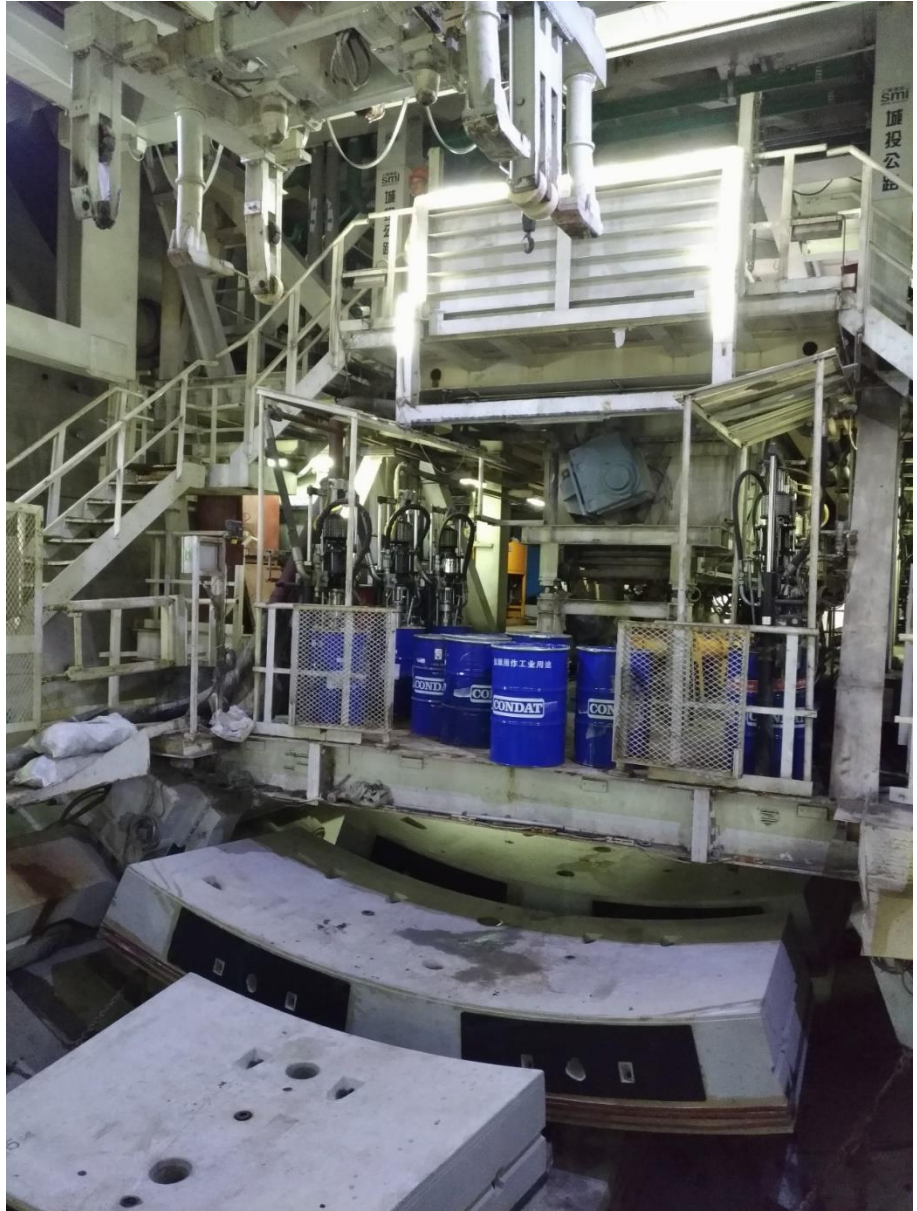
圖 14：開挖泥漿回收作業區
