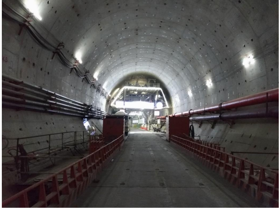
圖 12：上海北橫通道新建工程隧道內部
