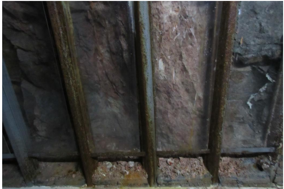
圖 26：破裂帶支撐與斷層泥
