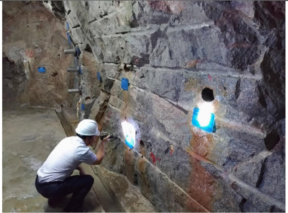
圖 24：側坑監測坑室
