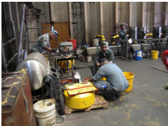
馬達拆裝檢修
