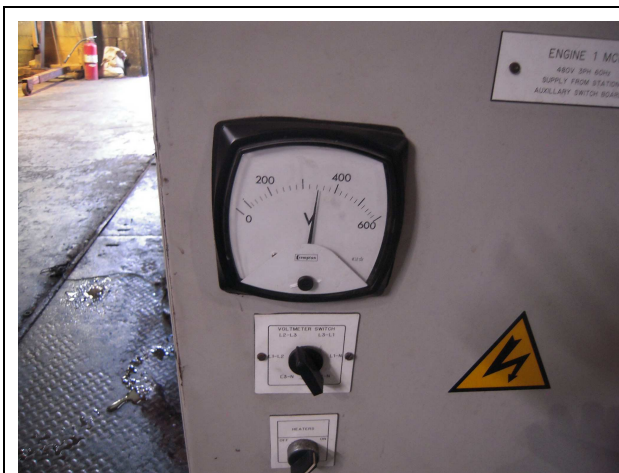
指示 370V 故障電表（正確 480V）
