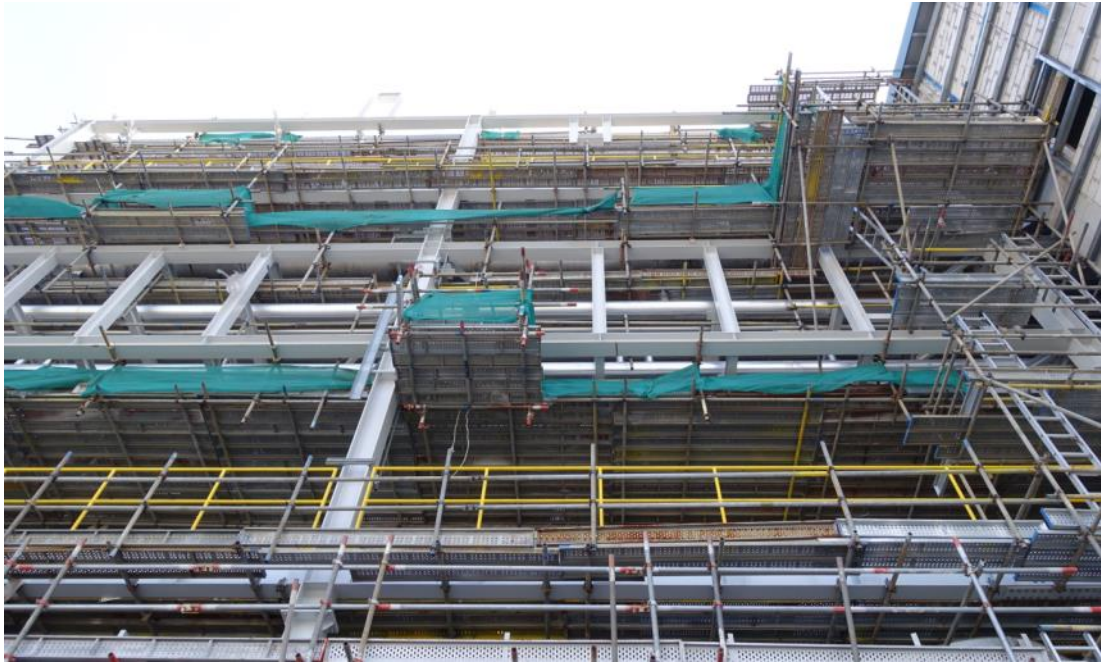
Verdezyne 正在建置中的生質二元酸試量產工廠，搭架防護很確實。
