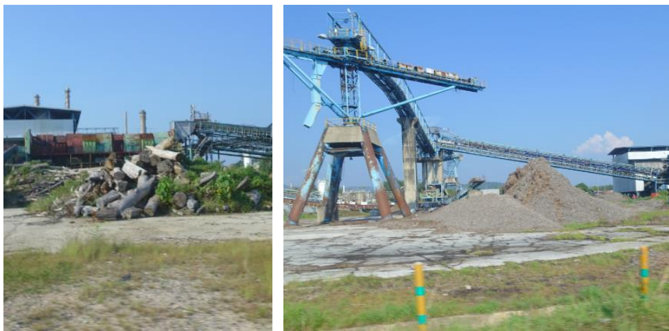
廢木材、廢木屑集中堆放。
