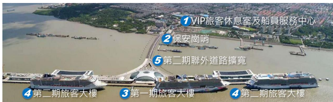
圖 6、吳淞口碼頭的現況外觀 (網路照片，本報告自行整理)
