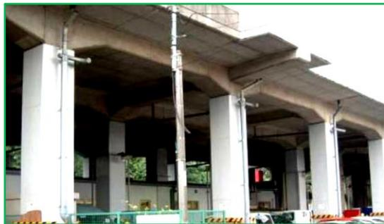
圖 2 東北新幹線之橋柱補強
