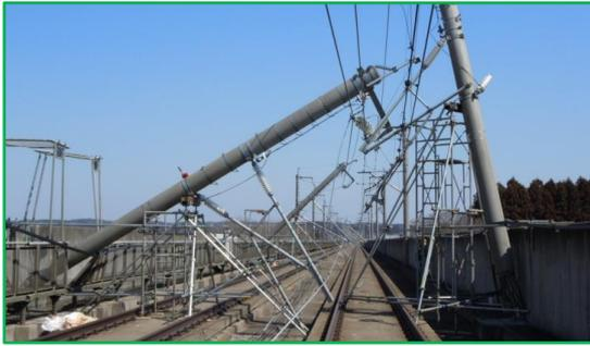
東北大地震電車線損壞情形
