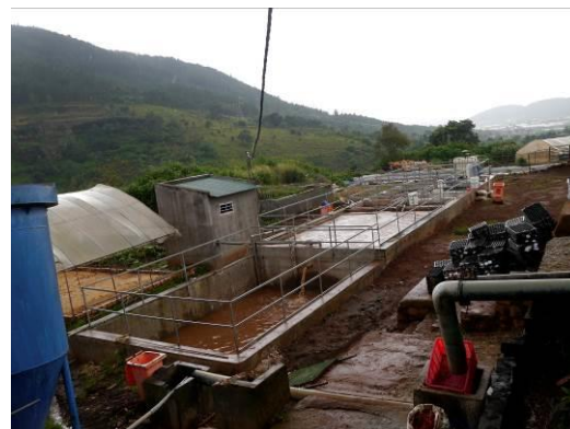
圖35、林台種苗公司收集及處理種子廢水池具有三段式處理的水池。
