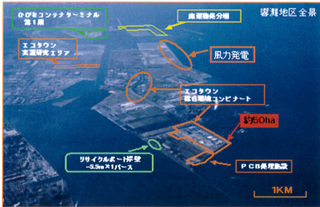
圖 18 Eco Town 園區全貌
