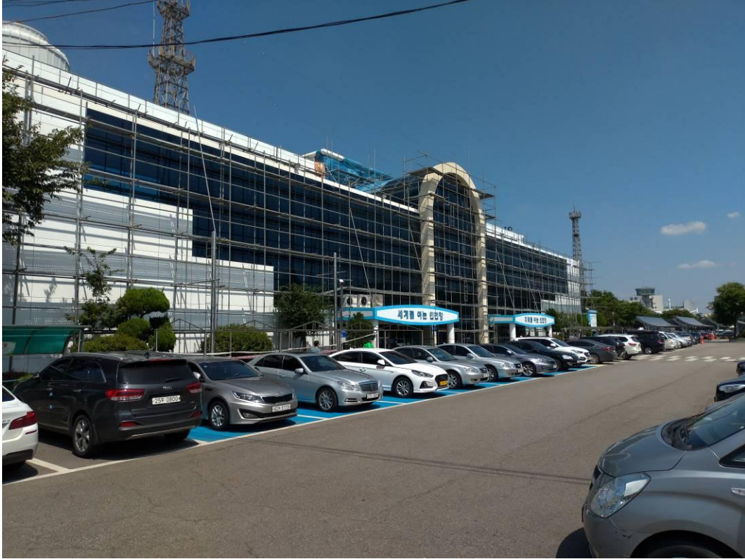
圖 40. 沿岸客運中心(正在施工中)
