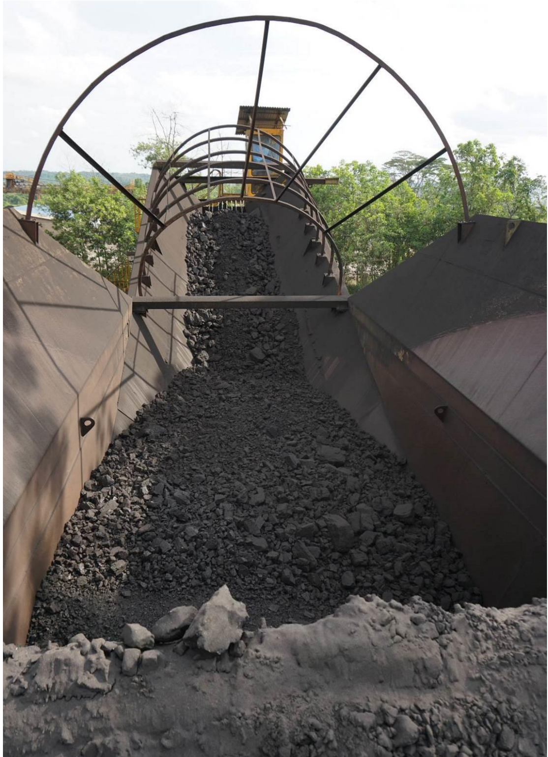
圖23 Separi Jetty碎煤機卡車卸料口
