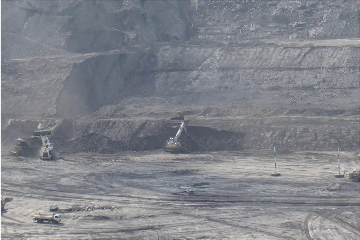
圖73 Cerrejon礦區Annex礦坑採煤作業
