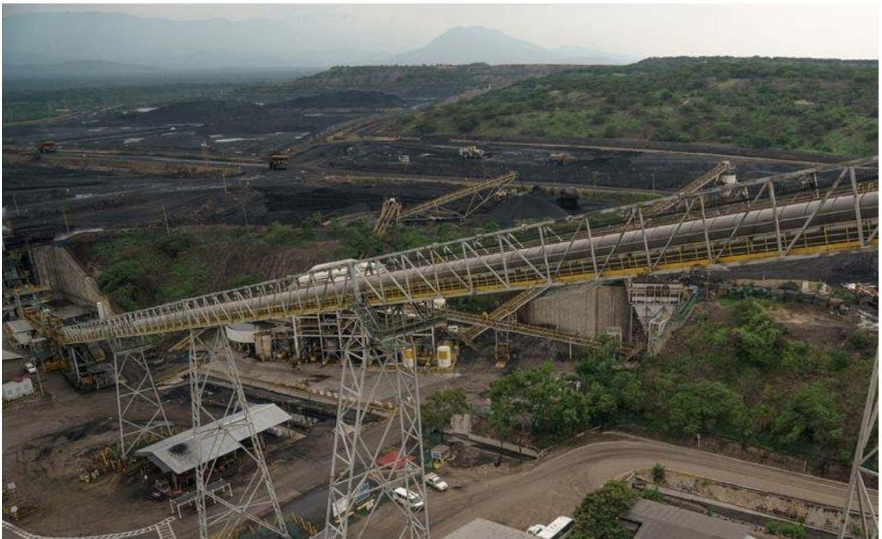
圖80 Cerrejon礦區原煤儲煤場與產品煤皮帶機
