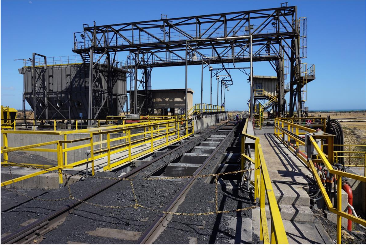
圖91 Puerto Bolivar火車卸煤站(底卸式)
