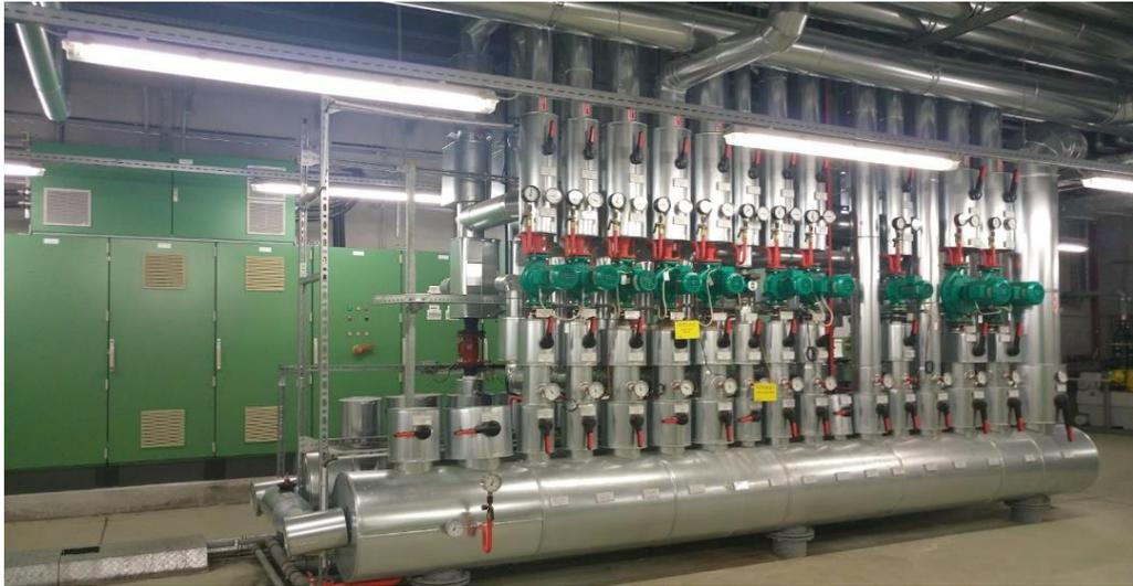
圖 11 司圖加特機場的空調系統水循環管路
