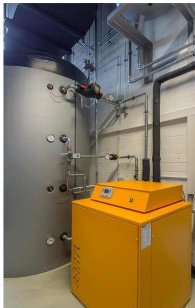
圖 9 Energy Park Hirschaid 的地下水熱泵系統
