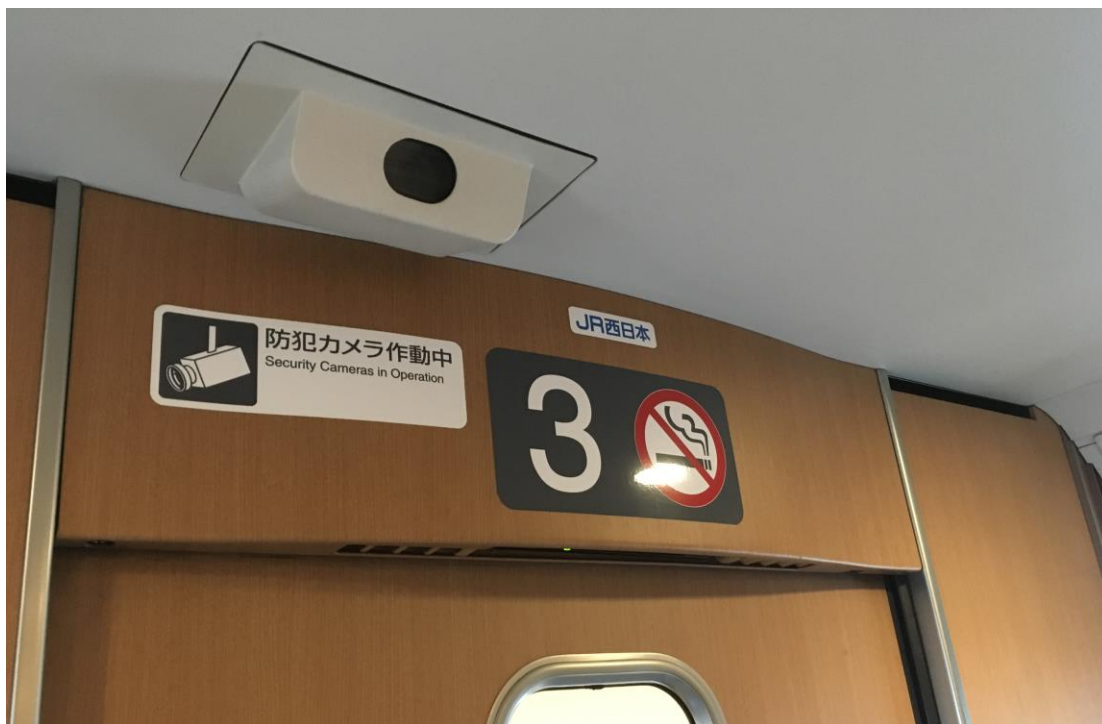
圖59 車廂監視器動作中警示標示
