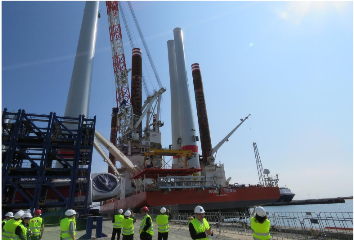
圖 33 自升船進行風力機塔筒裝船作業
