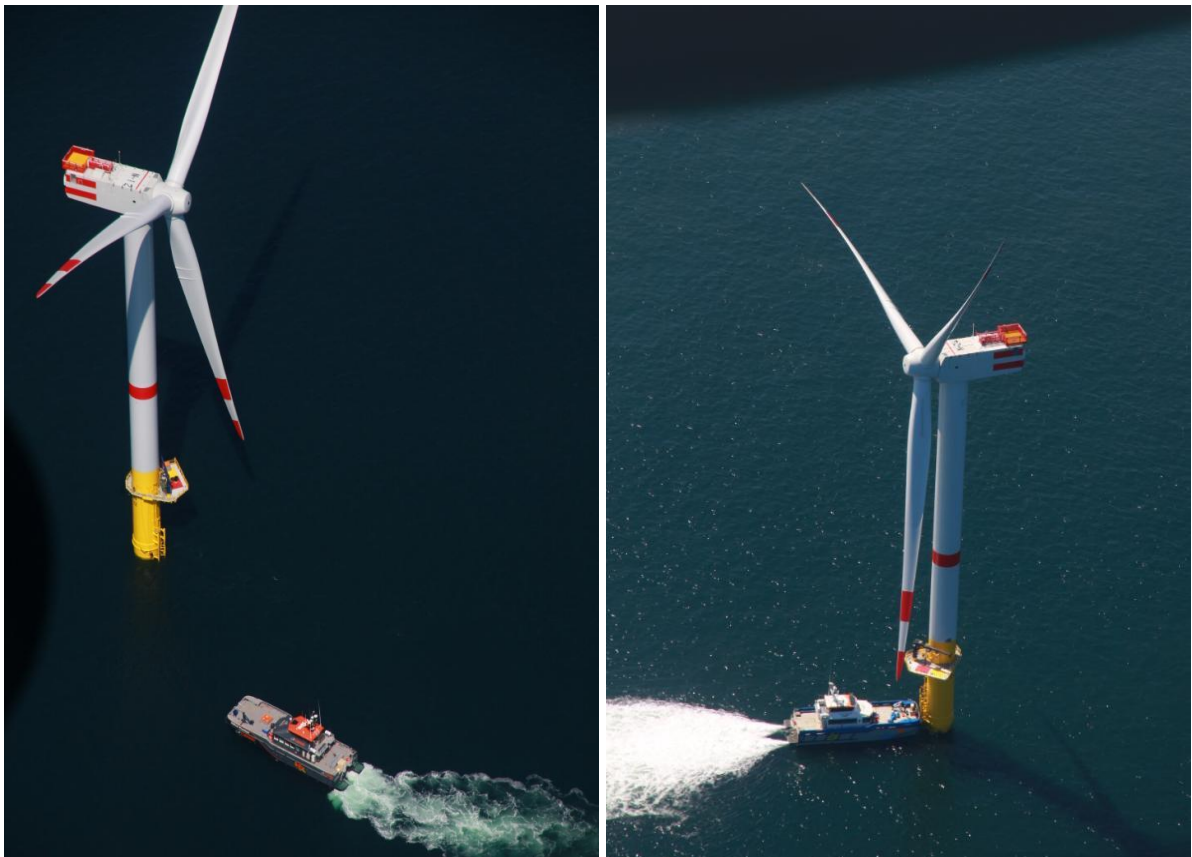
圖 8 Nordsee One 離岸風場-CTV boat landing 作業
