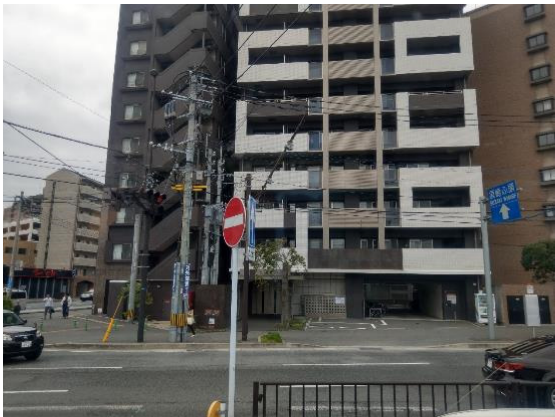
圖 2.3.1.4 車輛偵測器於福岡道路設置情形
