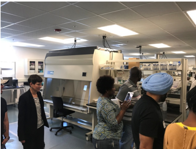
實驗室內所有插座皆設置於天花板，因此設備調整擺放的機動性很高。
