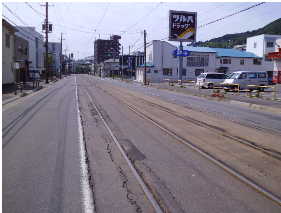
圖3.27 輕軌軌道設置在馬路正中央的路面配置設計
