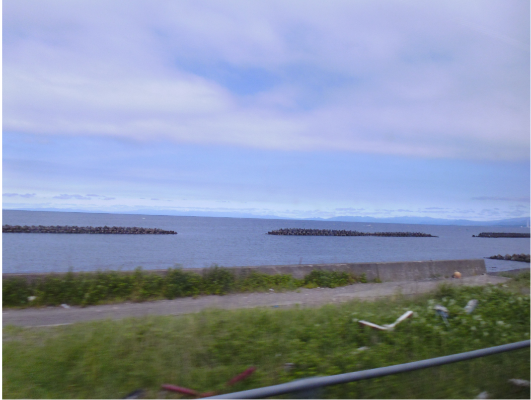
圖3.22 北海道海岸離岸堤設置情景
