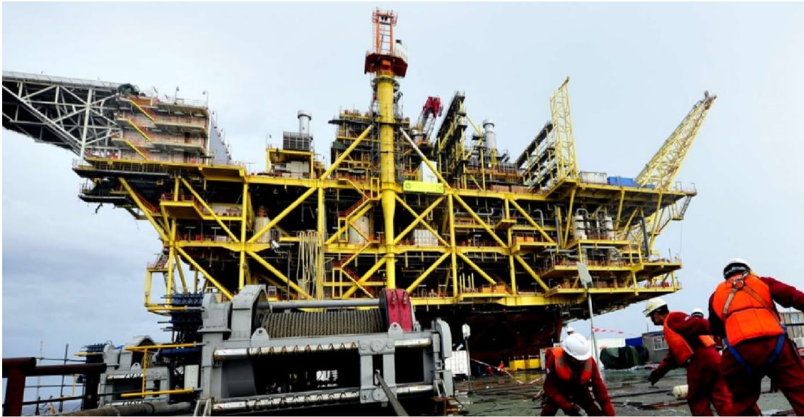
圖3.4 荔灣3-1中心平台組塊安裝施工(取自雙贏-中國海洋石油公司 2014年8月-李佑坤/攝)
