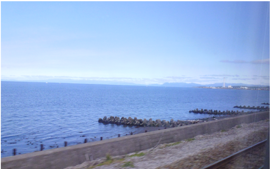
圖3.23 北海道海岸突堤設置情景
