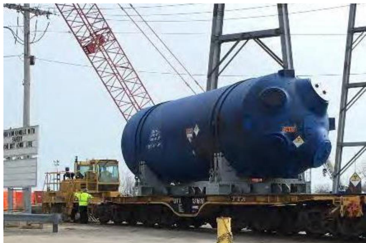
圖 16、Zion 電廠移除之蒸汽產生器
