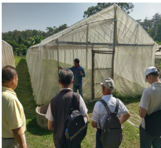
圖 3：茵他儂農場有機蔬菜溫室主結構材逐步由木竹改為鋁管。
