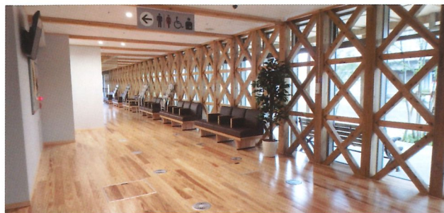
東館（議会棟）市オリジナル耐力壁
