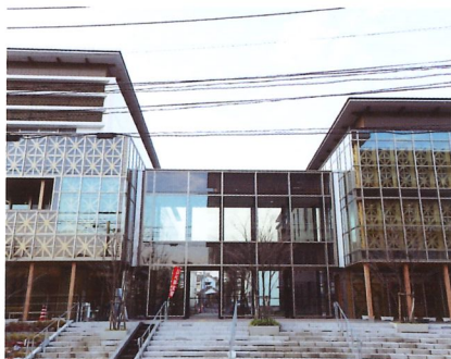
本館と東館をつなぐ連結部
