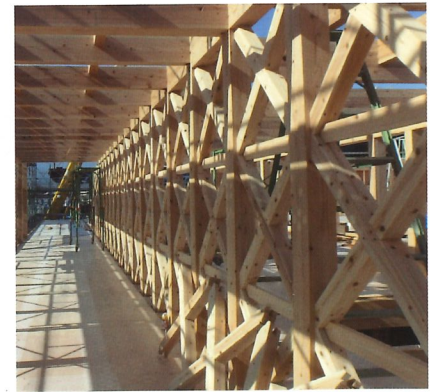
東館耐力壁の組立状況
