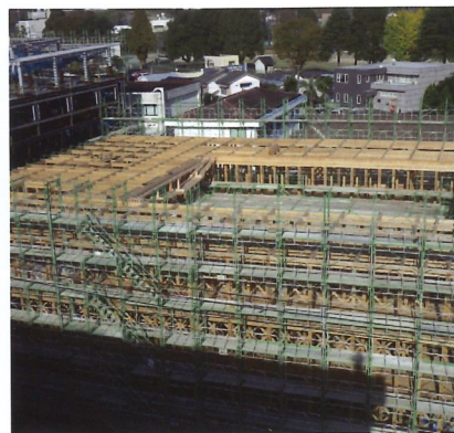
東館（議会棟）の木組建て状況
