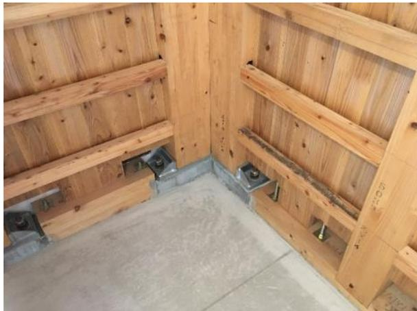
圖27. 建築物的內部構造，利用鋼釘進行接集成材。
