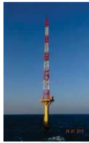
Met mast of Fuhai OWF
