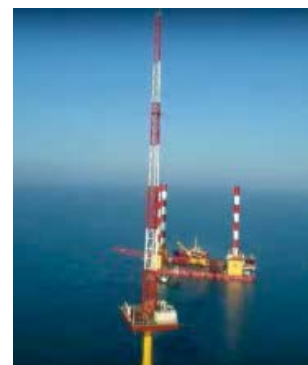
Met mast of Taipower OWF
