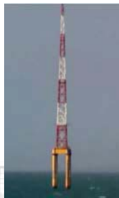
Met mast of Formosa OWF
