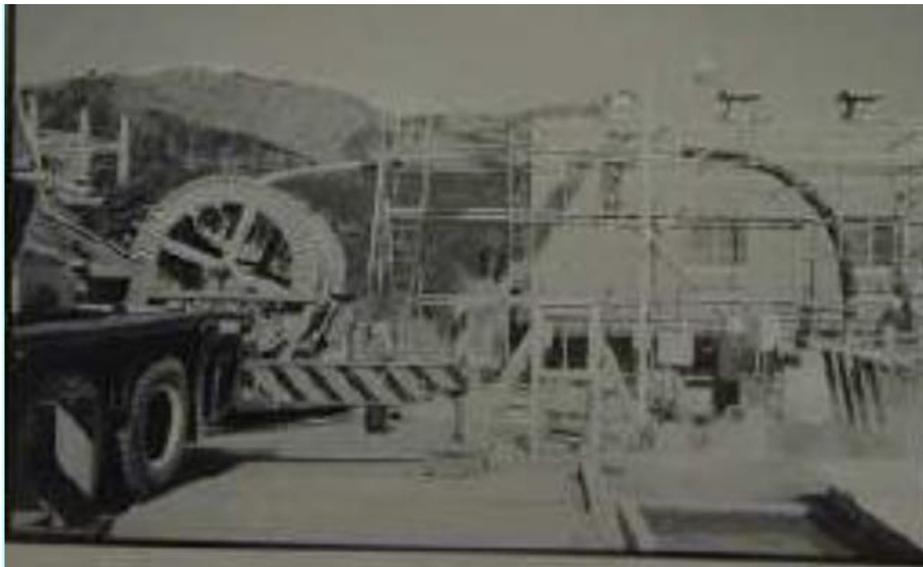
圖 15：日本 150 m 地熱能熱管現地安裝歷史照片 [5]
