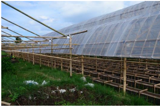
圖 137.玫瑰設施結構-3
