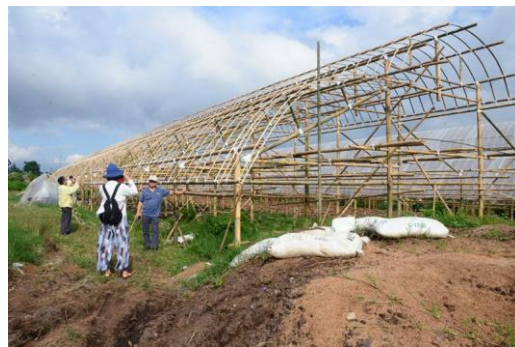
圖 136.玫瑰設施結構-2
