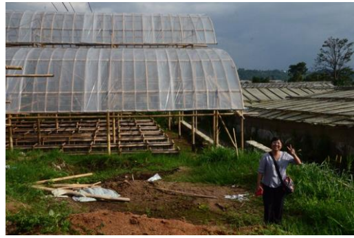
圖 138.玫瑰設施結構-4
