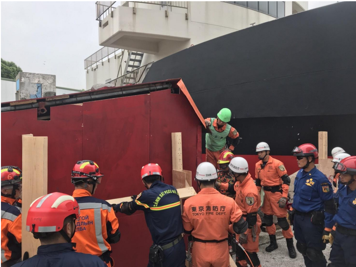
圖 9：國際搜救隊分組操作倒塌建築物牆面支撐
