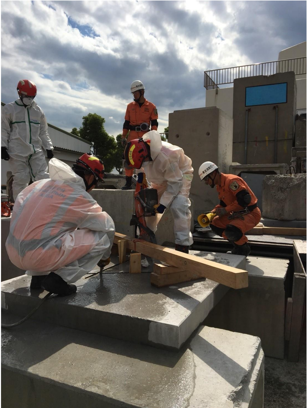
圖 24：臺灣搜救隊操作鋼筋混凝土乾淨切割
