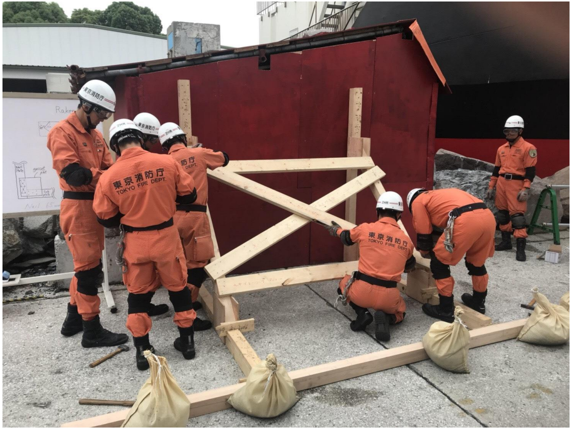
圖 7：東京消防廳示範倒塌建築物牆面支撐作業技術
