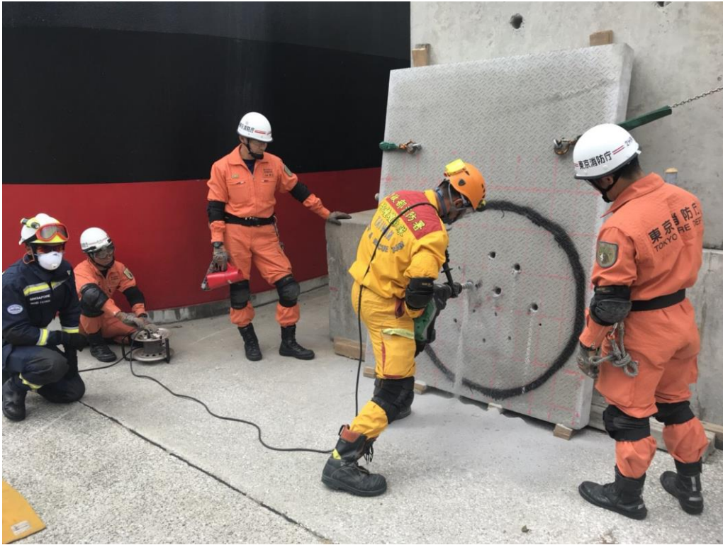
圖 14：臺灣搜救隊操作鑽孔機作業
