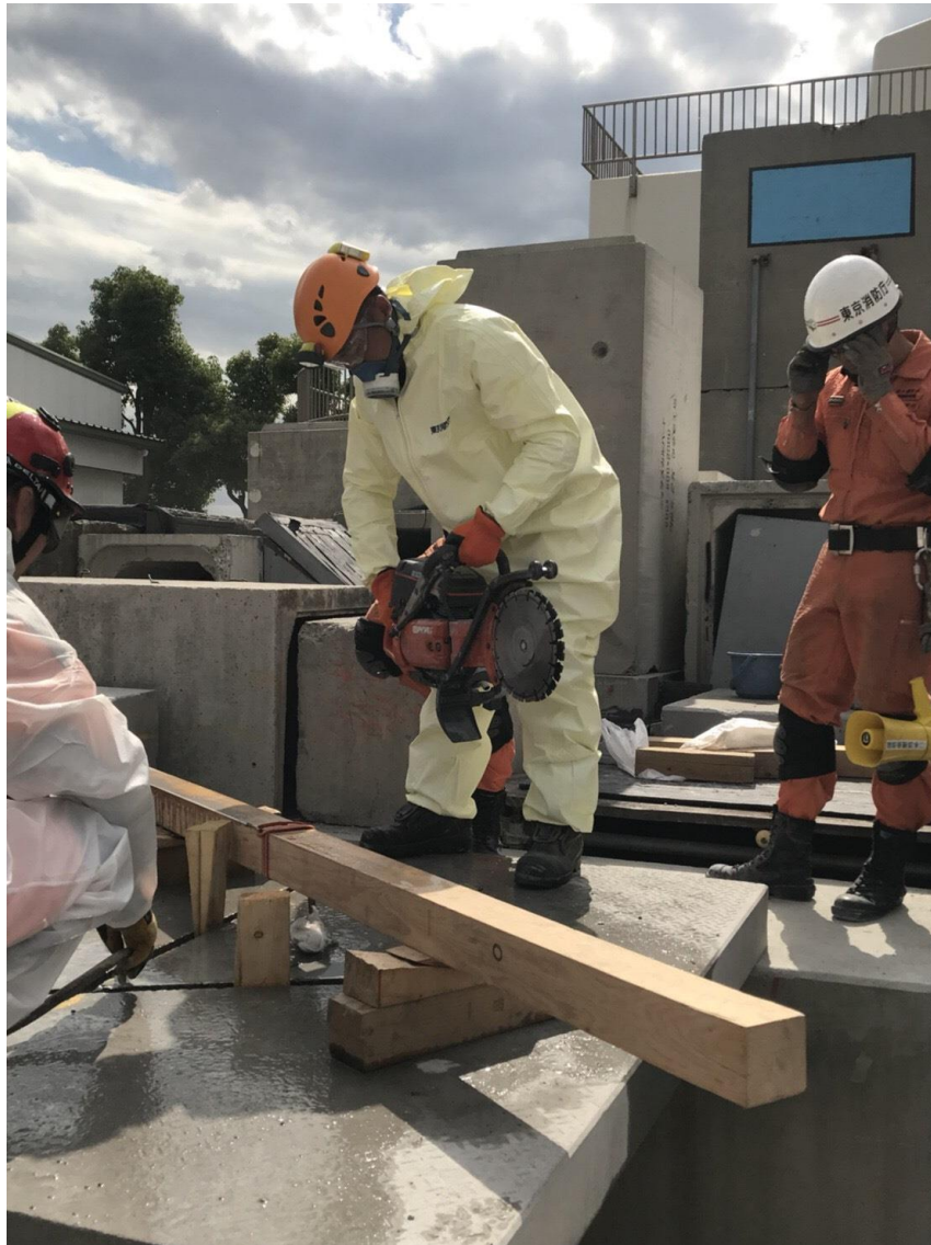
圖 23：臺灣搜救隊操作鋼筋混凝土乾淨切割
