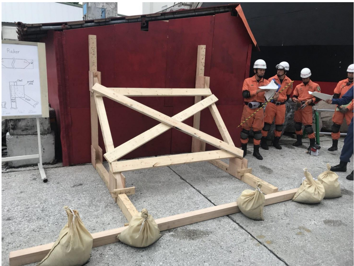
圖 10：國際搜救隊完成倒塌建築物牆面支撐作業
