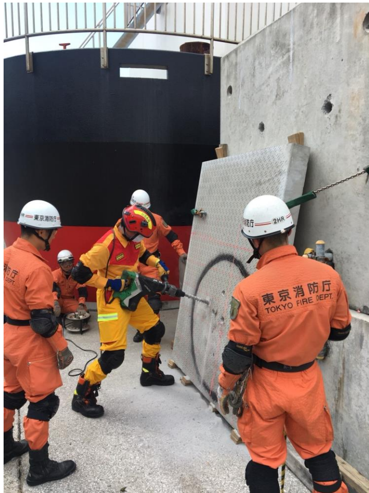
圖 15：臺灣搜救隊操作鑽孔機作業
