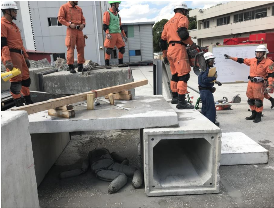
圖 25：東京消防廳圖示講解將鋼筋混凝土完成切割後吊升作業方法
