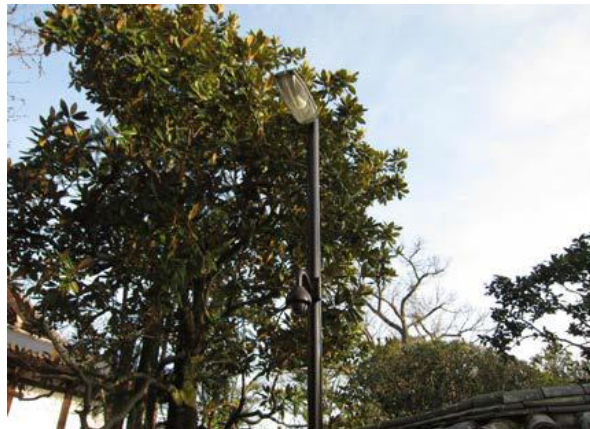
監控系統設備
