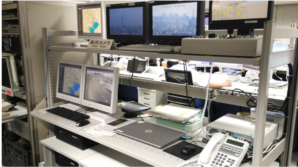
圖 46 將東京都空拍實況影像傳回災害救急情報中心
