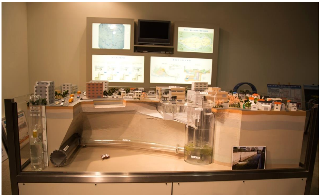
圖 51 第 7 號環路地下調節池模型
