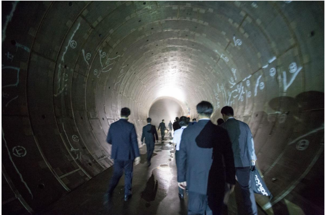
圖 50 進入第 7 號環路地下調節池管道參觀
