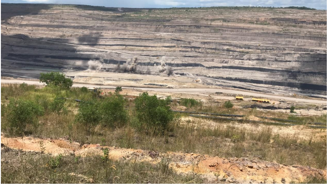
Tutupan 開採區域實施爆破作業
