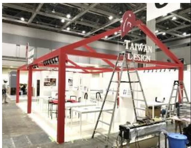
現場施工狀況 1
