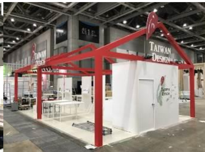
現場施工狀況 2
