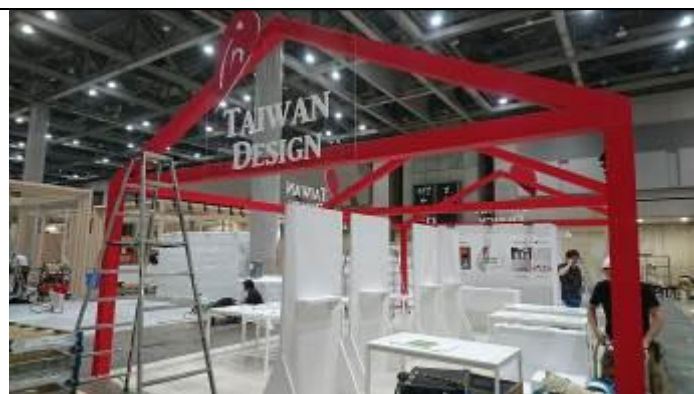
委辦廠商進行展場施工 2
