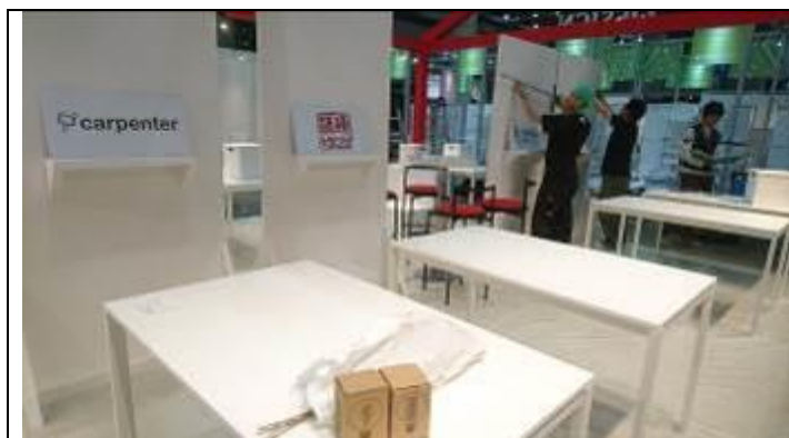
委辦廠商進行展場施工 1
