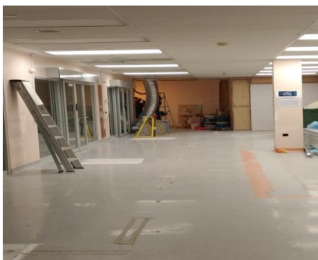
排風設備依施工範圍增設機具
