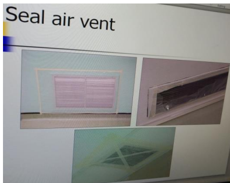
出風口、通道及洞口等皆必須以強力膠布(dust tap)密封
