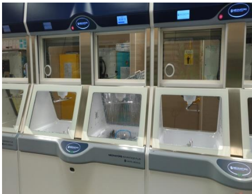
清洗間和打包區以自動清洗機當隔間
