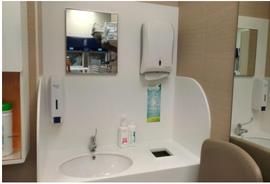
打包區洗手槽設備
