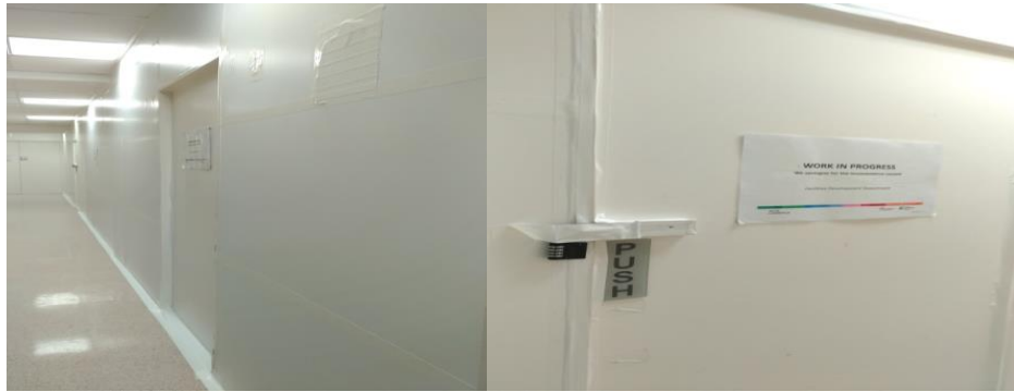
施工範圍之圍籬防護非常落實，各接縫處再以強力膠布再封黏
