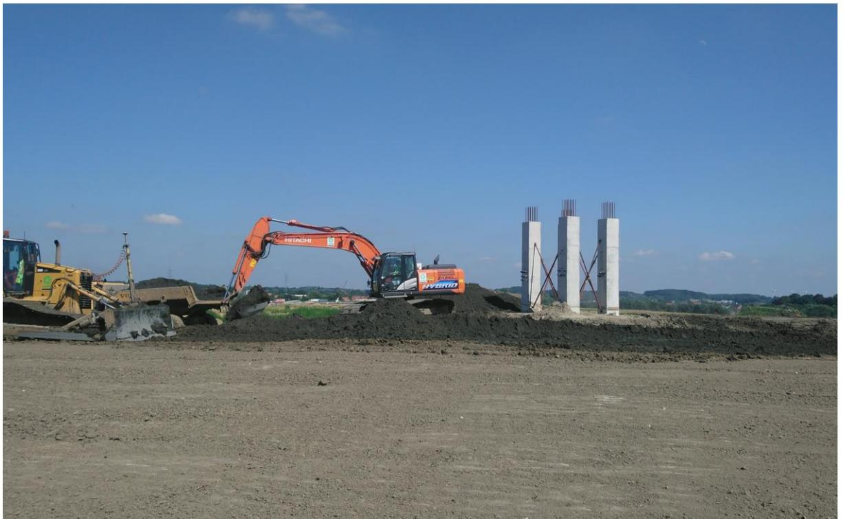
圖 1-3-3. 汙染土壤回收中心（Fasiver）土丘上方所預留之基樁
