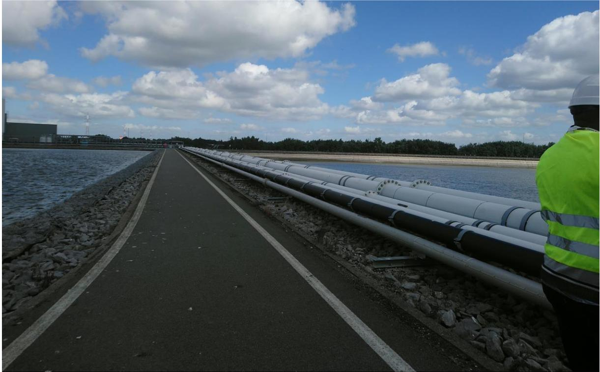
圖 1-2-11. 長達 3 公里之浚挖泥砂運送管線（及回收水運回管線）
