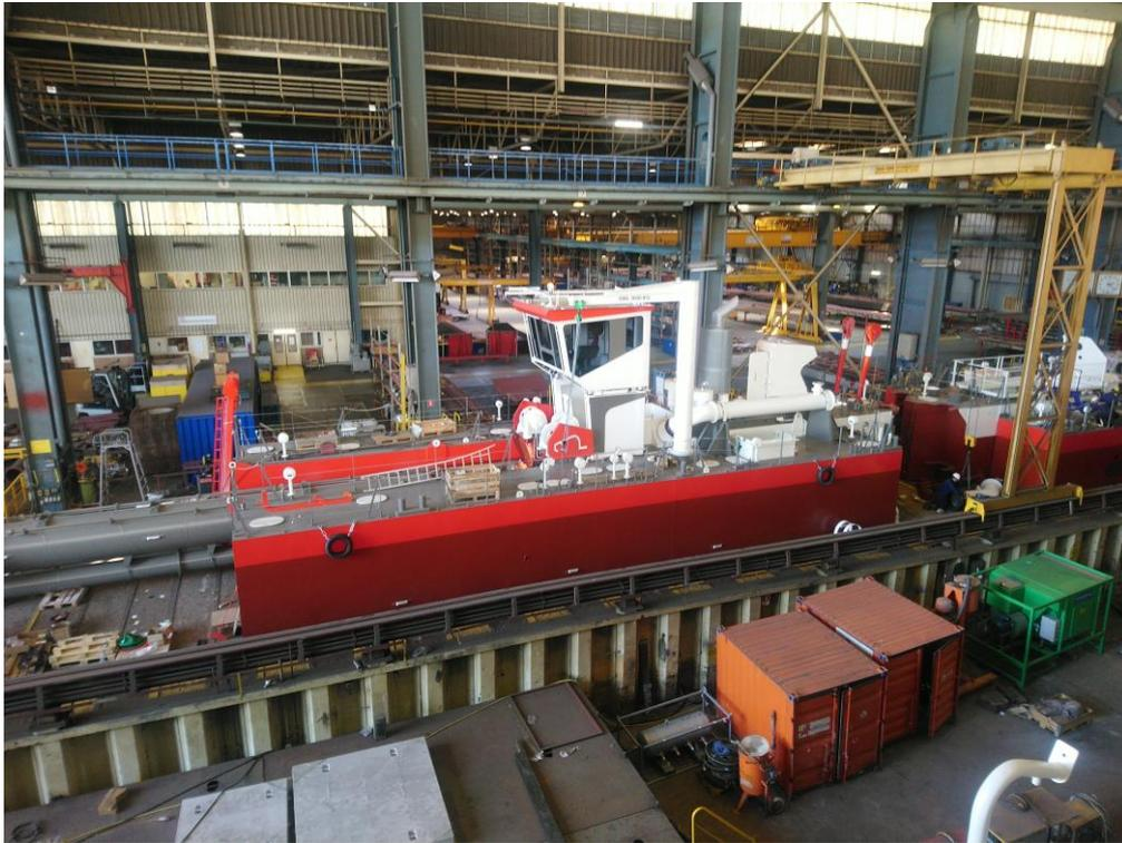
圖 1-3-20.組裝中的絞刀式浚挖船 Beaver 50CSP
