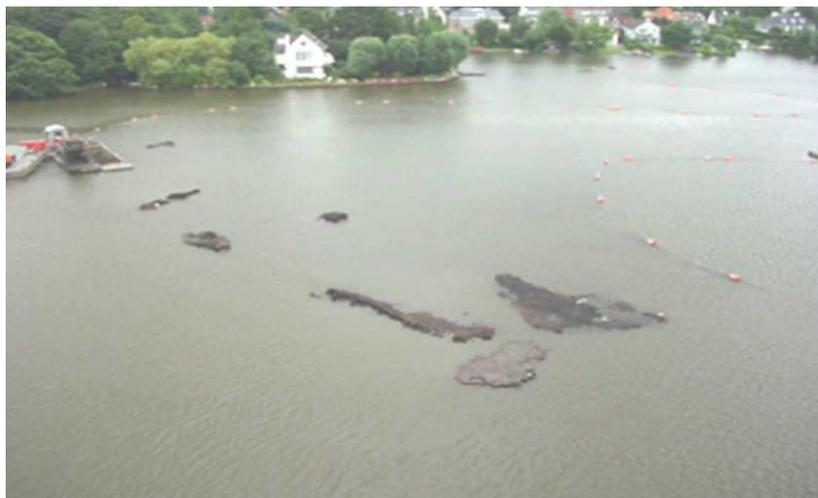
圖 1-4-1. 浚挖過程中有汙染物質配合污染防止膜避免溢散<sup>\*1</sup>
