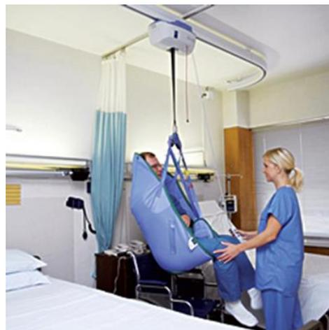
圖九、天軌移位設備（相近示意圖）
