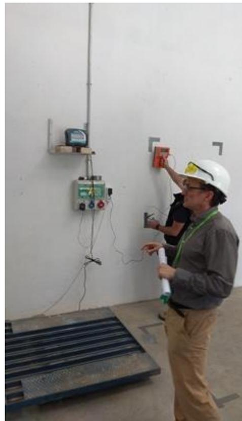
圖二十三、José Cabrera 核電廠解除管制量測室—廠房壁面污染量測
