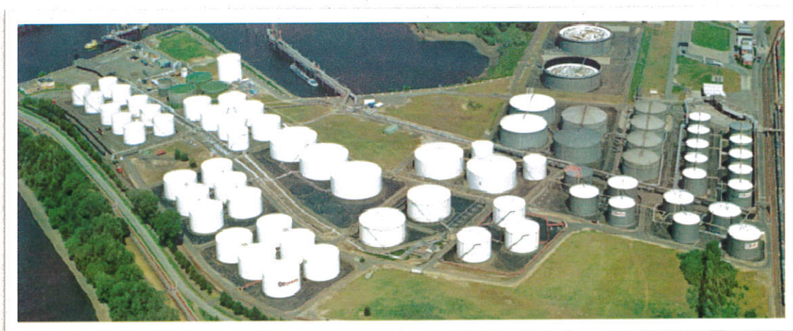
圖 7 漢堡港 Oil tanking 公司儲油設備
