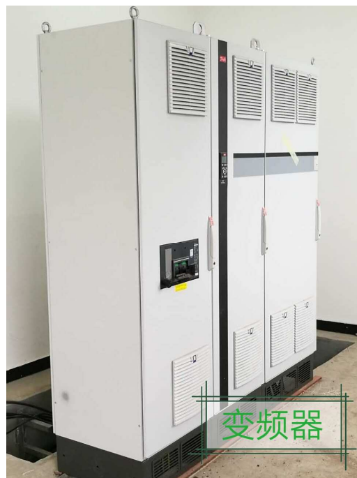
圖 6 成都校檢站大型風機變頻器系統
