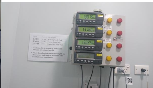
圖 12、種菌保存室即時監測液態氮保存桶氮含量，確保保存環境恆定。
