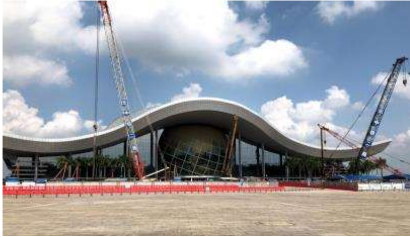
▲圖 37 科學中心前方施工中的輕軌工程
