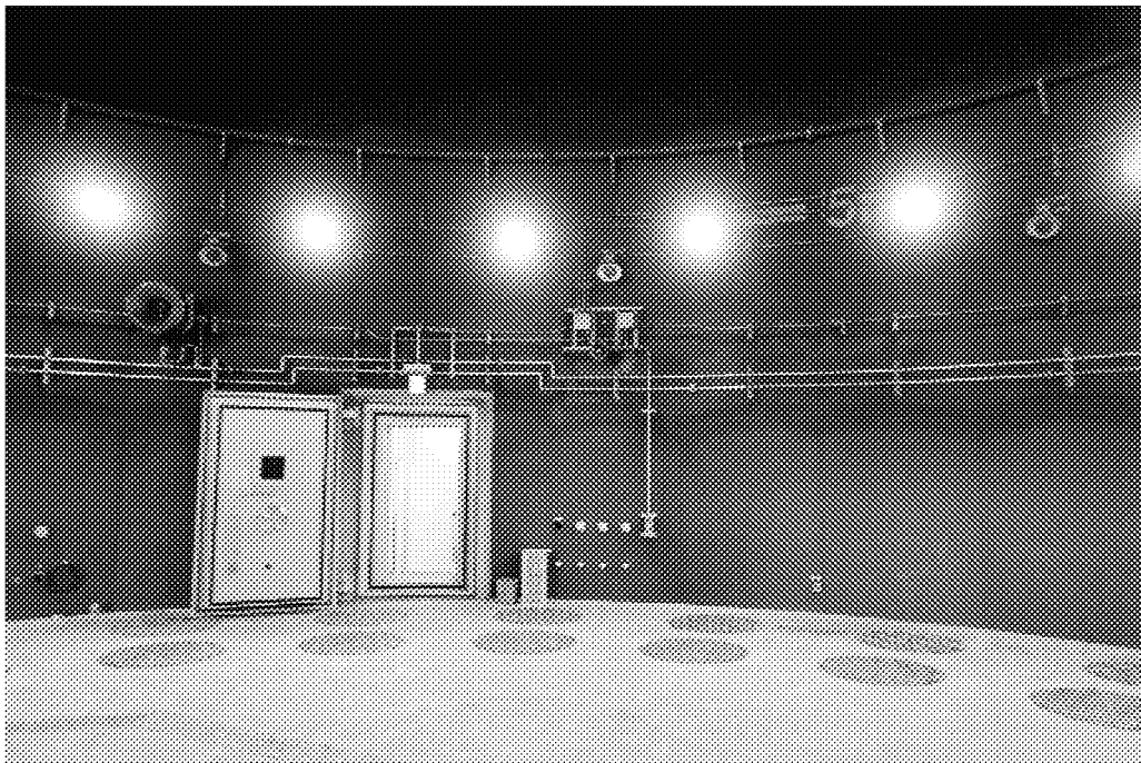
圖 19 可容下 40 呎貨櫃 Large Chamber 內部照片
