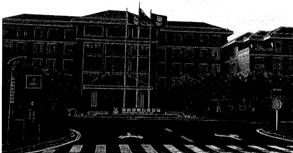
圖一、海南昌江核電廠行政大樓
