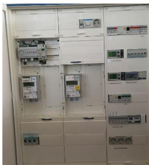
太陽光電與儲能系統的整合控制技術
