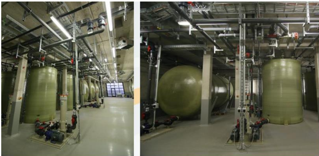
圖15 氧化還原反應液流電池(Redox Flow battery)系統 (資料來源：Dr. Stefan Tröster簡報資料)
