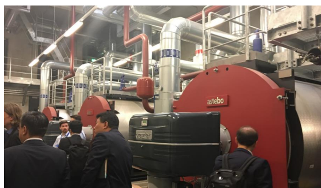
柴油發電機電廠設備
