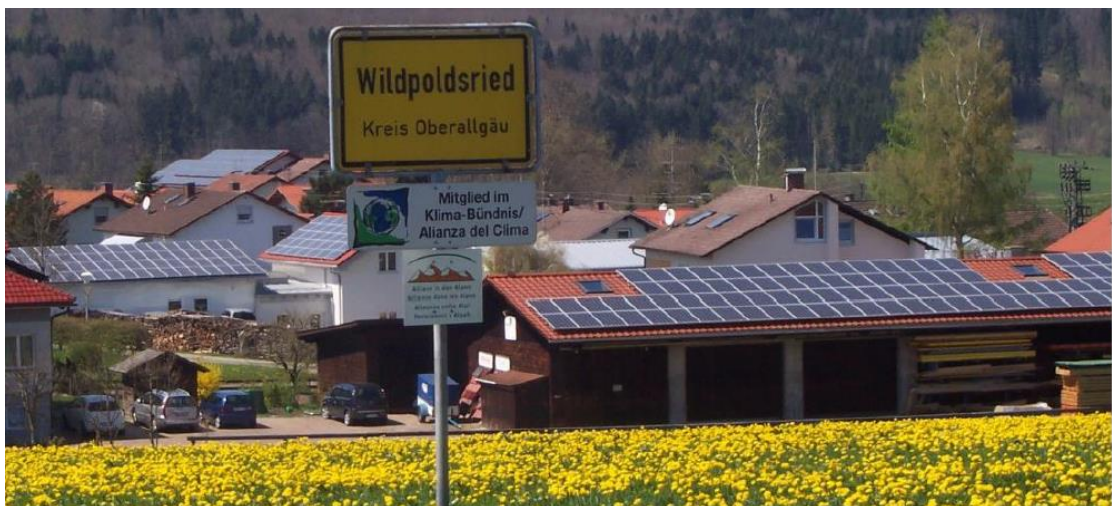
圖34 全鎮350多家的屋頂都設有太陽能板
