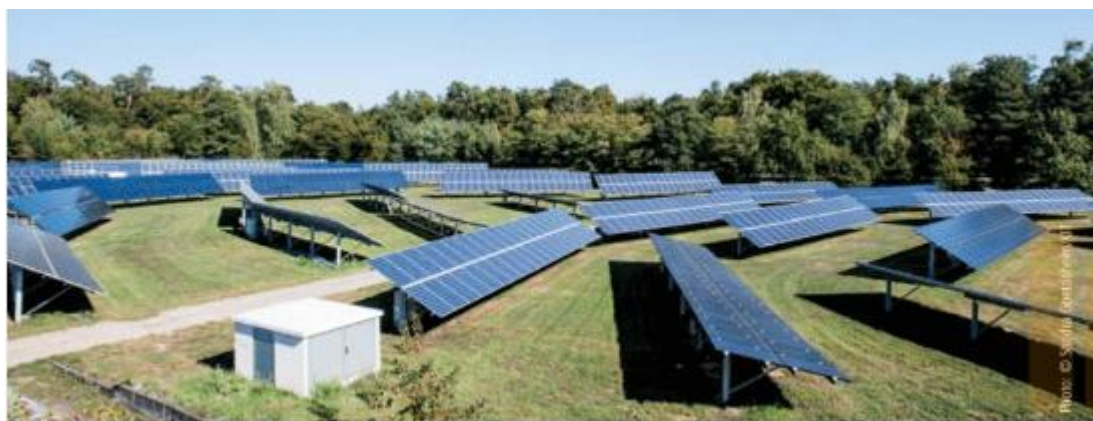
圖 67 太陽光電場域以不同之垂直角度與方向配置進行測試研究
