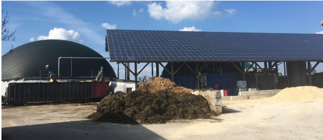
圖37 生質能(Biomass)儲氣槽、青草、玉米和其他生物質
