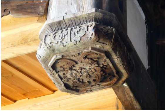
華人重視的吉祥、招財等寓意在當地的傳統客家建築裡同樣隨處可見。圖為下方刻有蝙蝠、側邊刻有鳴吻圖樣的托木。
