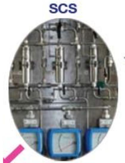
從照片中可知系統設計複雜且元件眾多，尤其在管線的連接 Fitting 數量非常多及特殊，從機率上而言連接處越多，又安裝於局限的小箱體內造成通風不良，縱使極低的 VOC 洩漏量卻無法自然溢散，累積成高濃度造成人體或環保危害因子。這種應用方式是現今分析儀器普遍性之樣品前處理方法。但此設備與 VOC 減量是背道而馳的。
