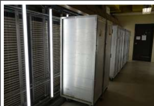
發芽育苗室以直立日光燈管搭配發芽櫃透明壓克力背板提供幼苗光源
