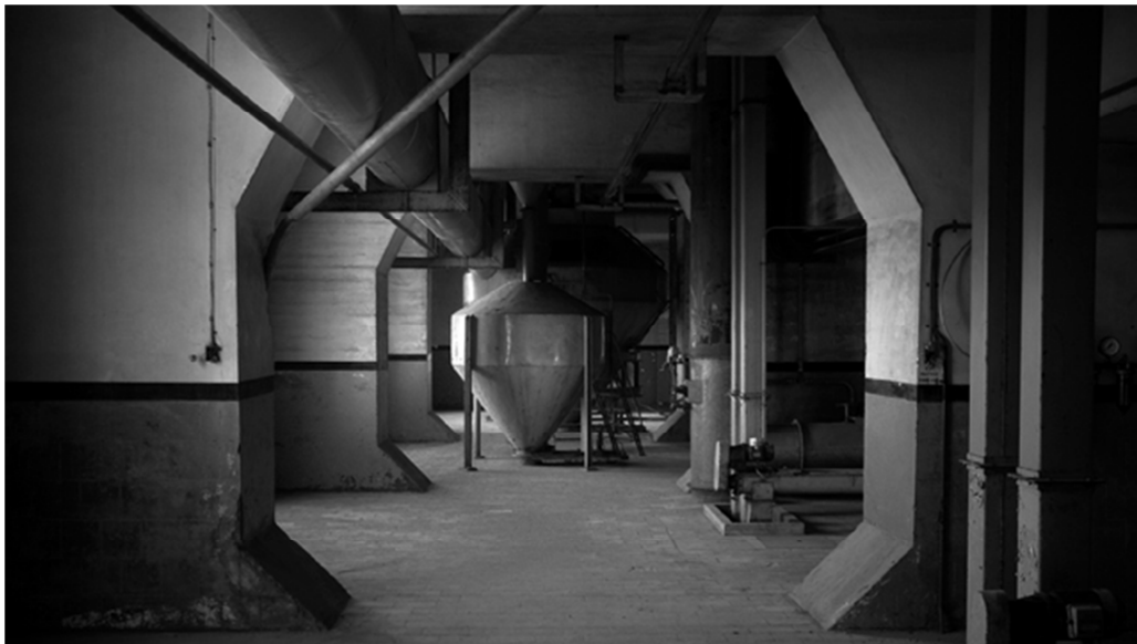
圖 20 舊釀酒廠內部舊裝，改造後仍完整保留。
