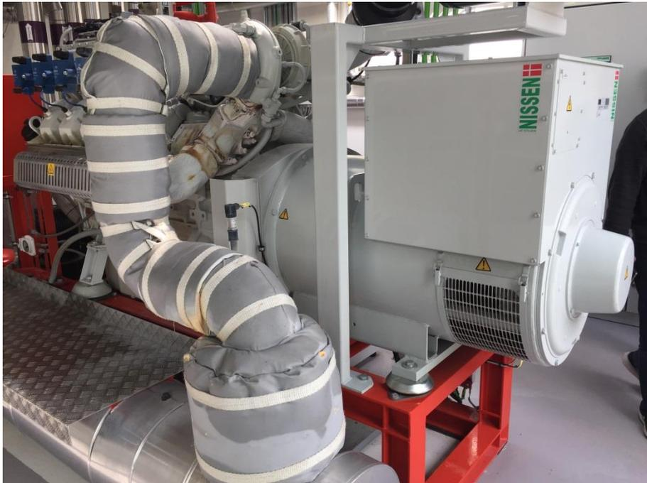
圖 19 沼氣發電熱交換機與管線隔熱包覆情形
