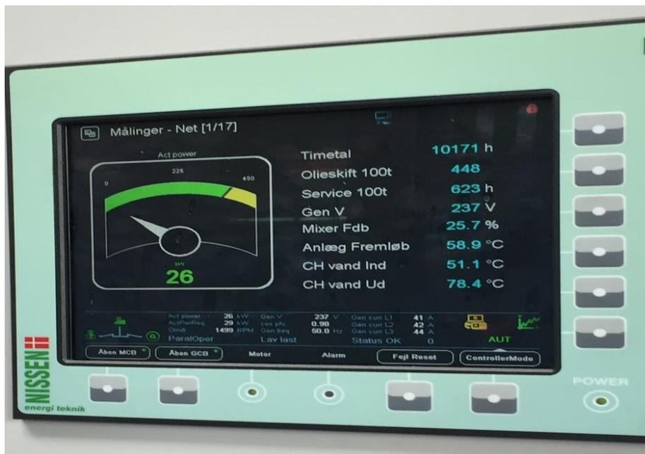
圖 21 沼氣發電機操作面板（已運轉 10,171 小時）
