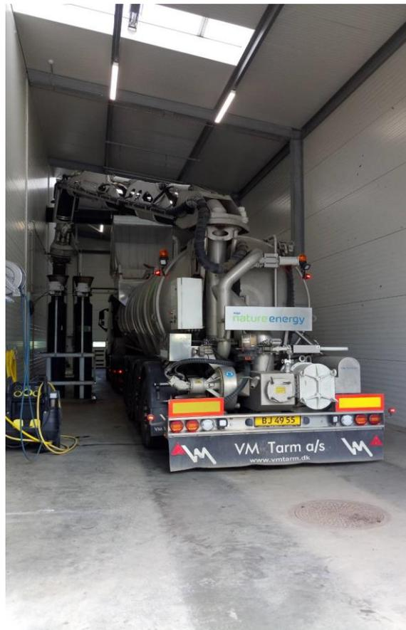
圖 46 沼肥輸送站及槽車載運抽取（真空抽氣）情形
