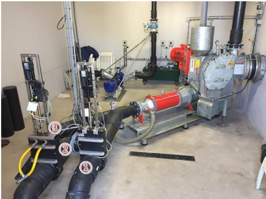
圖 29 共消化料源以輸送泵分送不同消化槽
