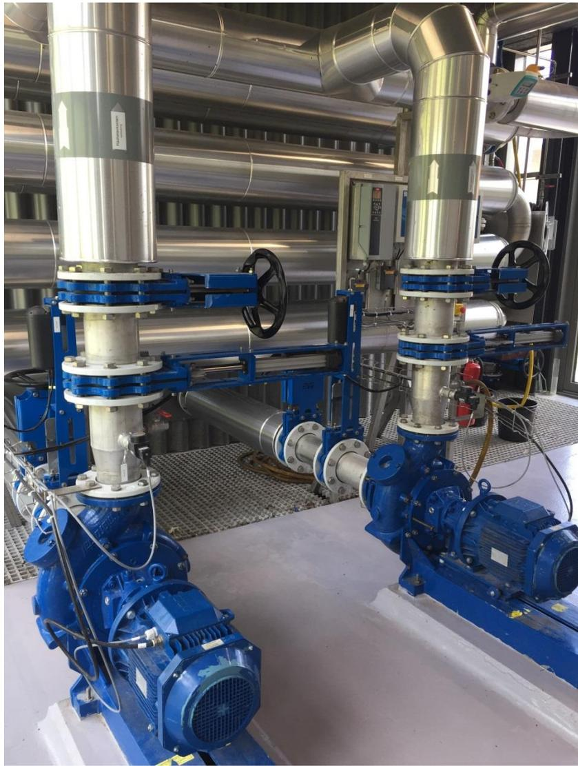
圖 22 汽電共生系統廢熱回收裝置
