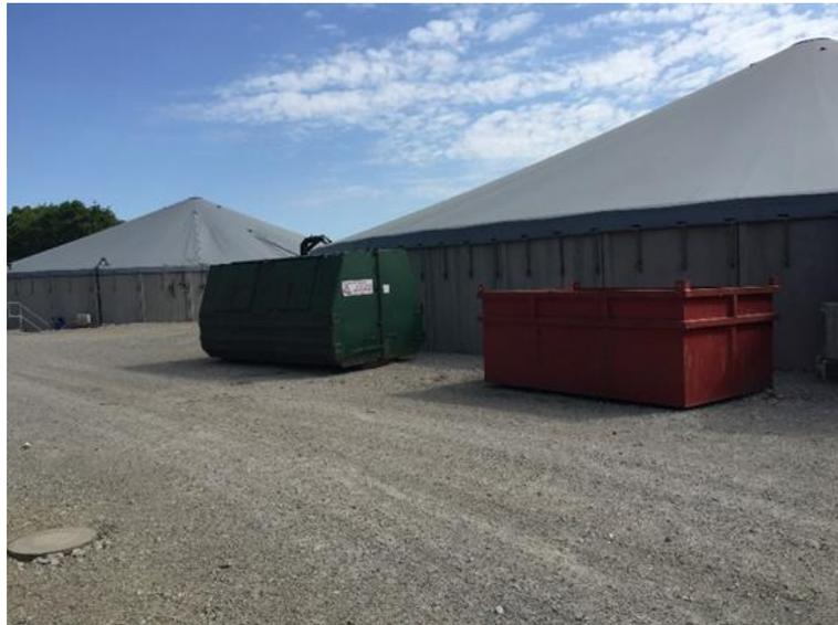
圖 44 混合後物料暫存槽及沼肥儲槽
