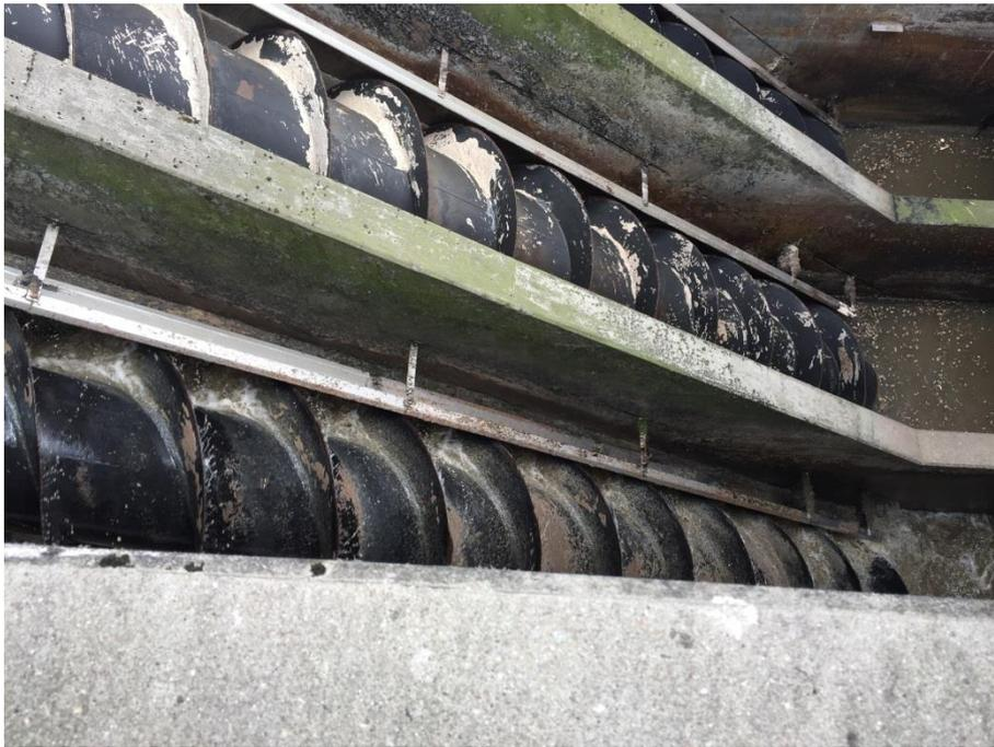
圖 17 螺旋式污水進流設備
