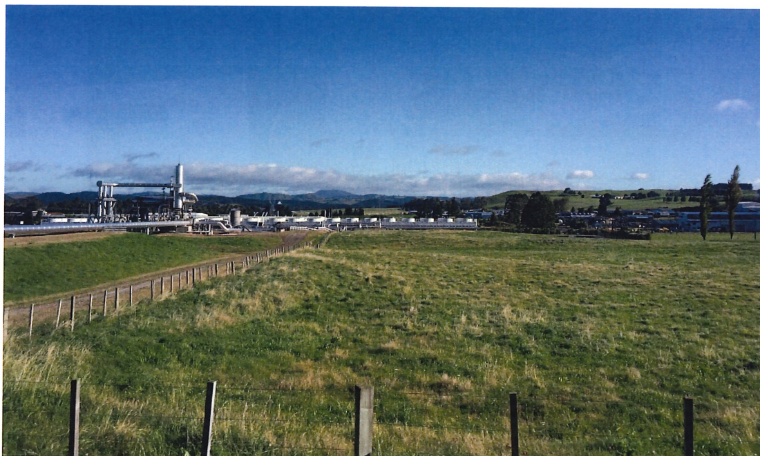
照片 1 Te Huka 地熱電廠廠區
