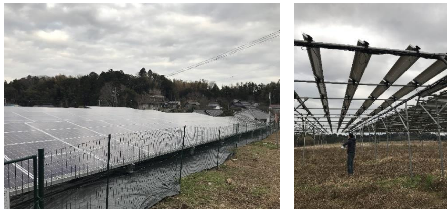
圖 7、日本一般地面型(左)與太陽能共享(右)面板裝設高度差異
