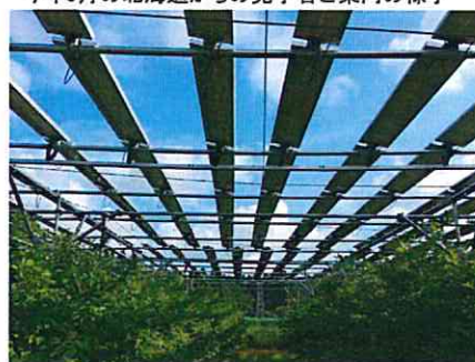
ブルーベリー畑の上は、遮光率:約34%に配置した太陽光パネル
