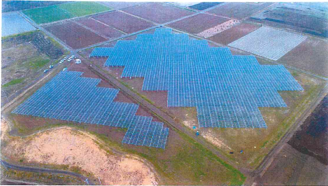
千葉県匝瑳市飯塚・開畑地域(75ha)のメガソーラーシェアリング事例:設備1MW、2.3haの農地、288世帯分の発電量 12
