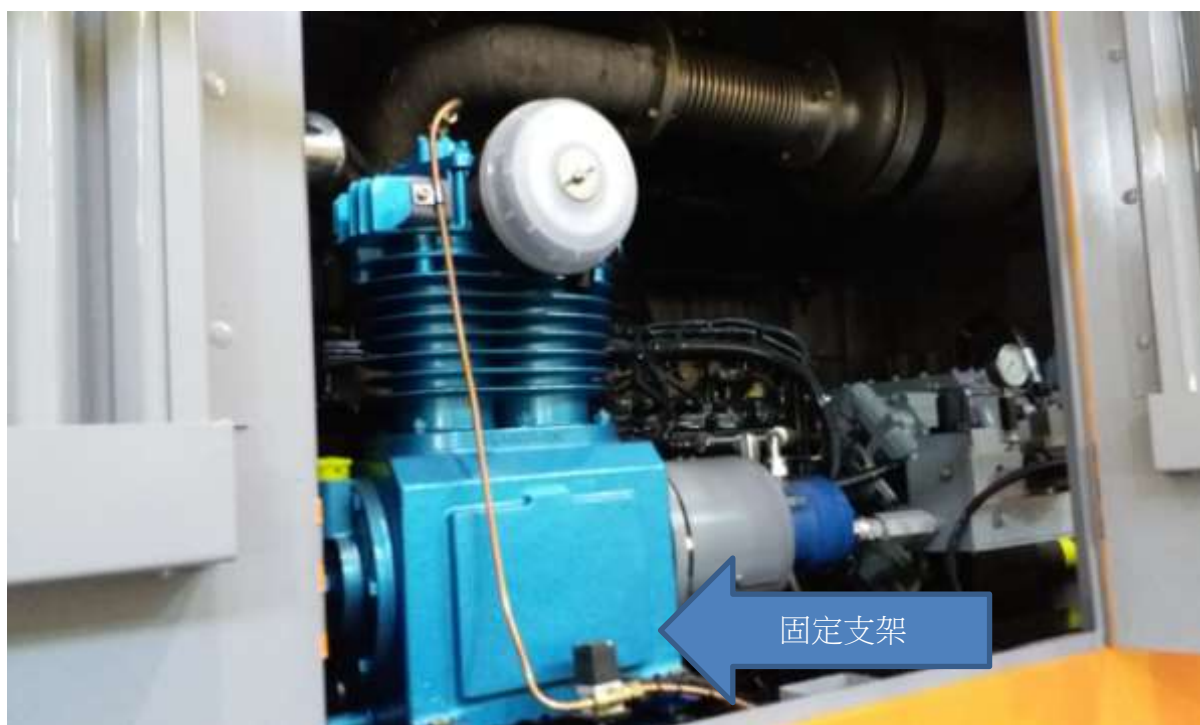
圖 16 空壓機改造固定支架照片
