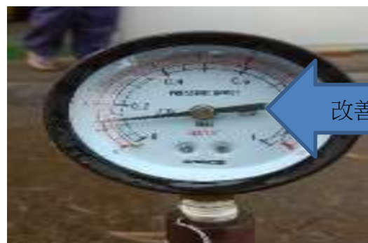
水壓無法達到 2\text{KG}/\text{CM}^2
