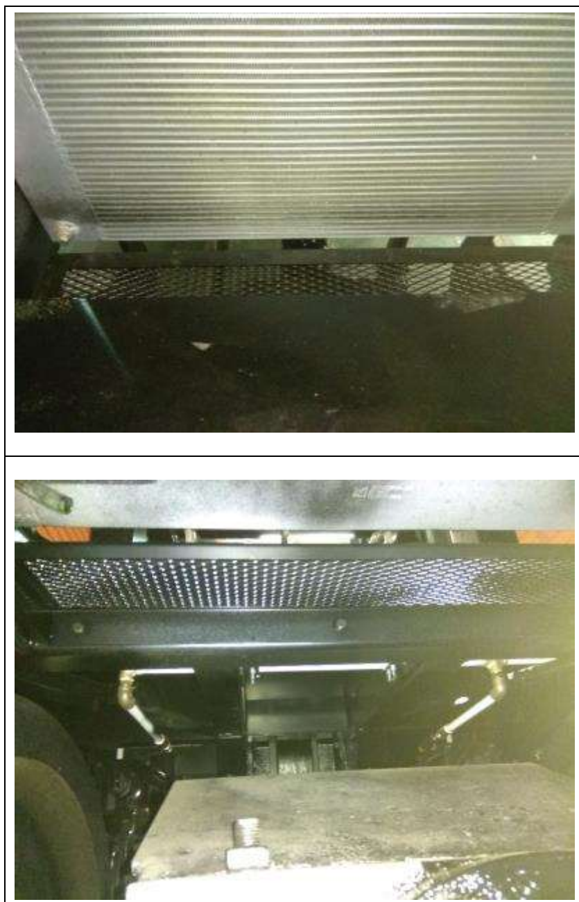
圖 14 散熱排下方裝設擋板完工照片
