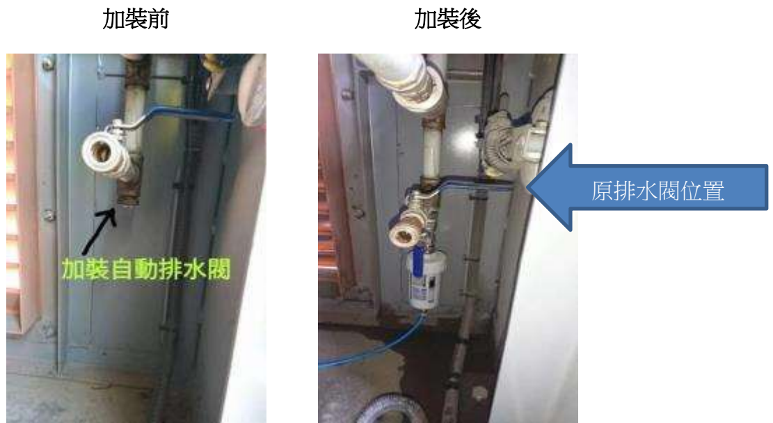
圖 7 原空氣槍管路加裝自動排水閥(排水閥位置修改之前)
