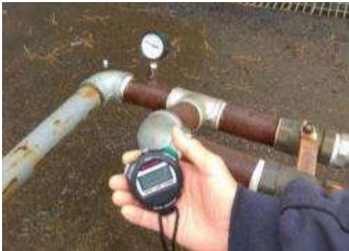
計時開始，確認水壓達 2\text{kg}/\text{cm}^2
