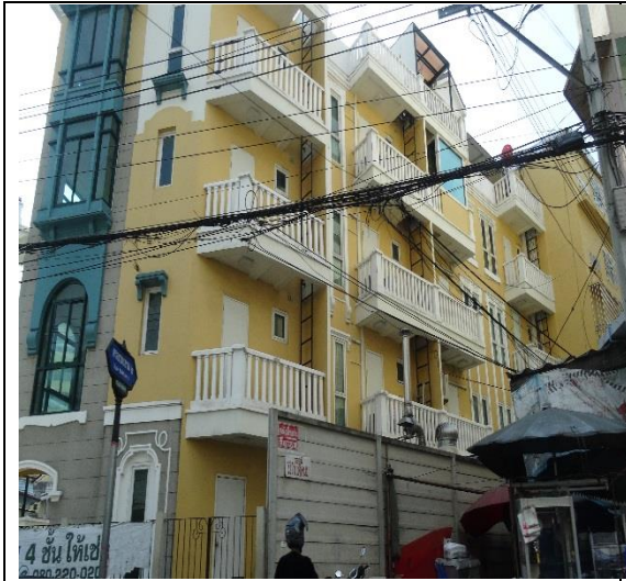
圖 17：在曼谷到處可見電纜線外露
