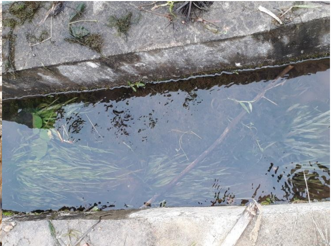
陸河縣螺溪鎮水溝
