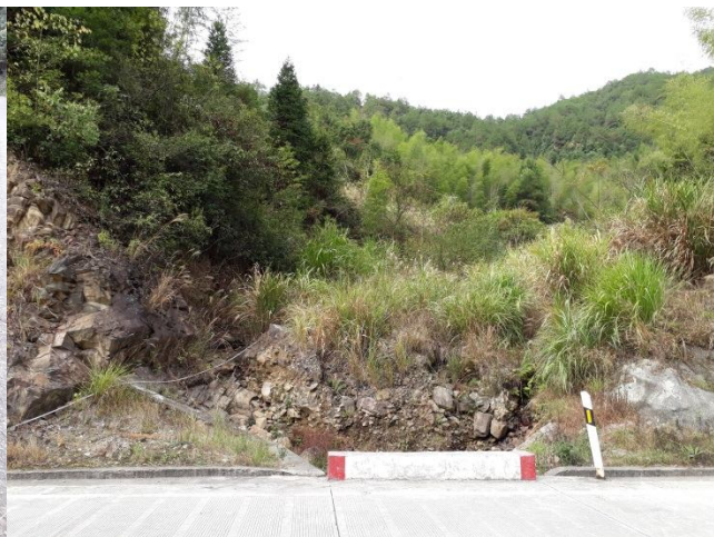
長汀縣新橋鎮龜嶺隧道
