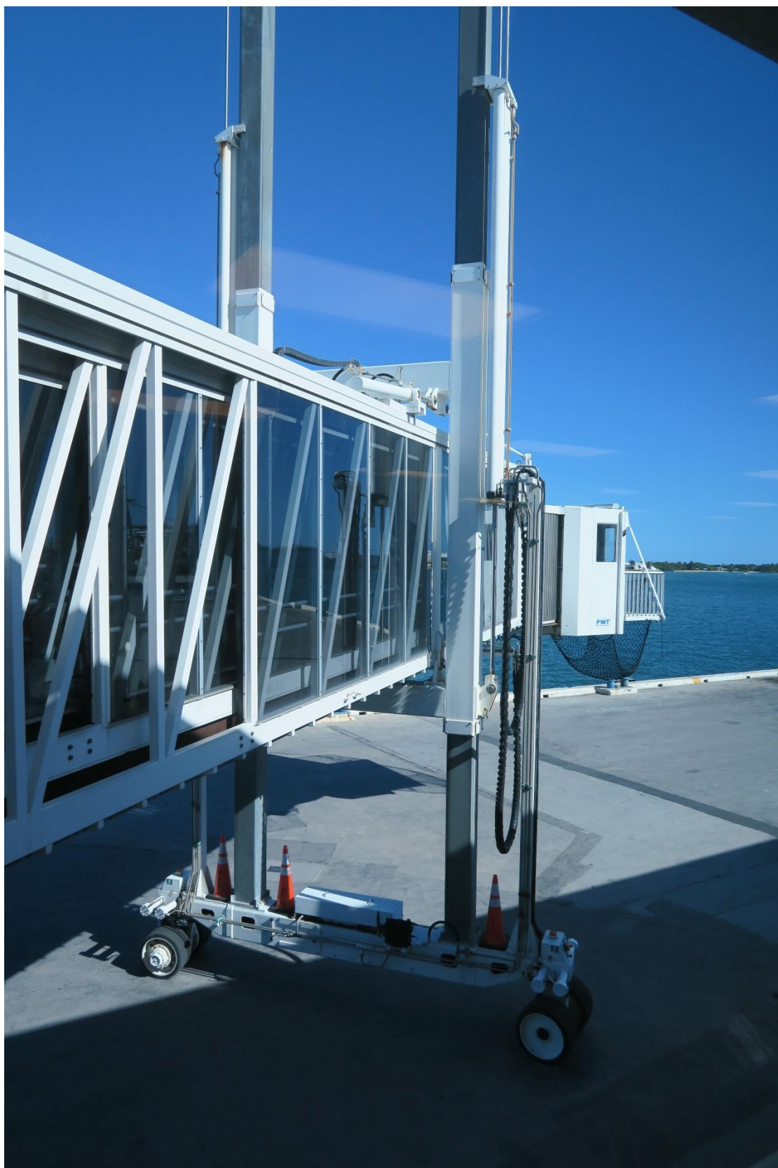
圖 59-60、設有兩座固定式旅客橋，搭配輪胎調整角度
