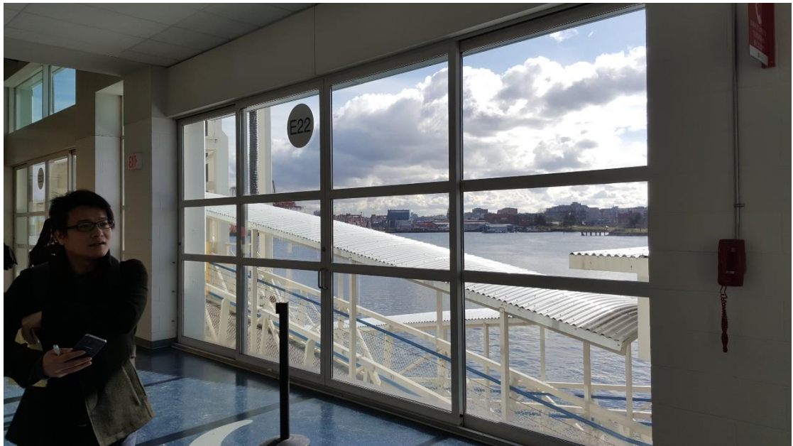
圖 77-78、海側搭橋口的每一道牆都可打開來搭橋，類似鋁門窗全開約近 3 米寬
