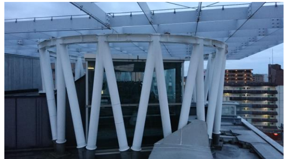
仙台媒體藝術中心屋頂結構
